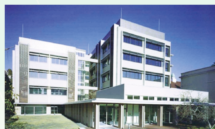
生命科学プロジェクト総合研究棟
