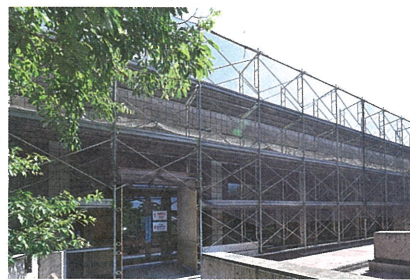
施工中の様子
