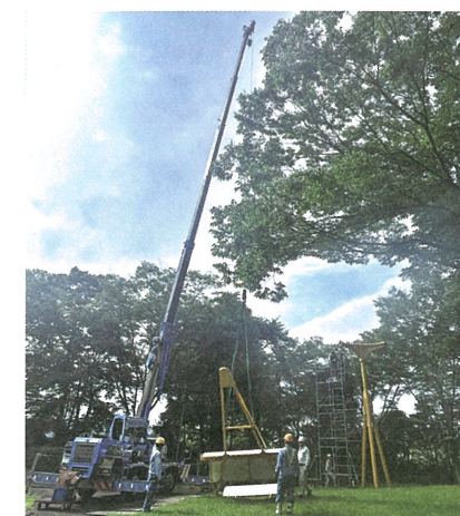
①クレーンによる羽の取り外し
