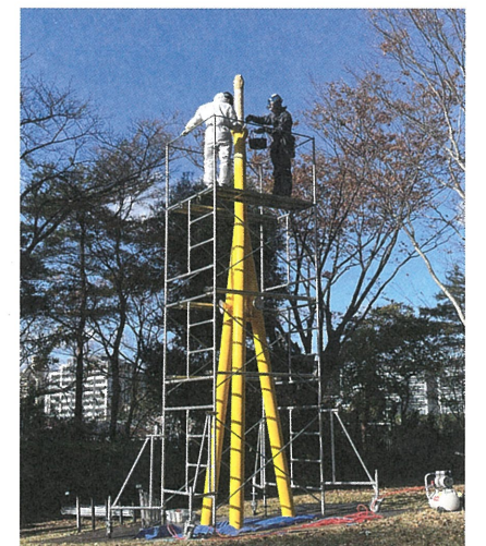
⑥支柱の塗装
