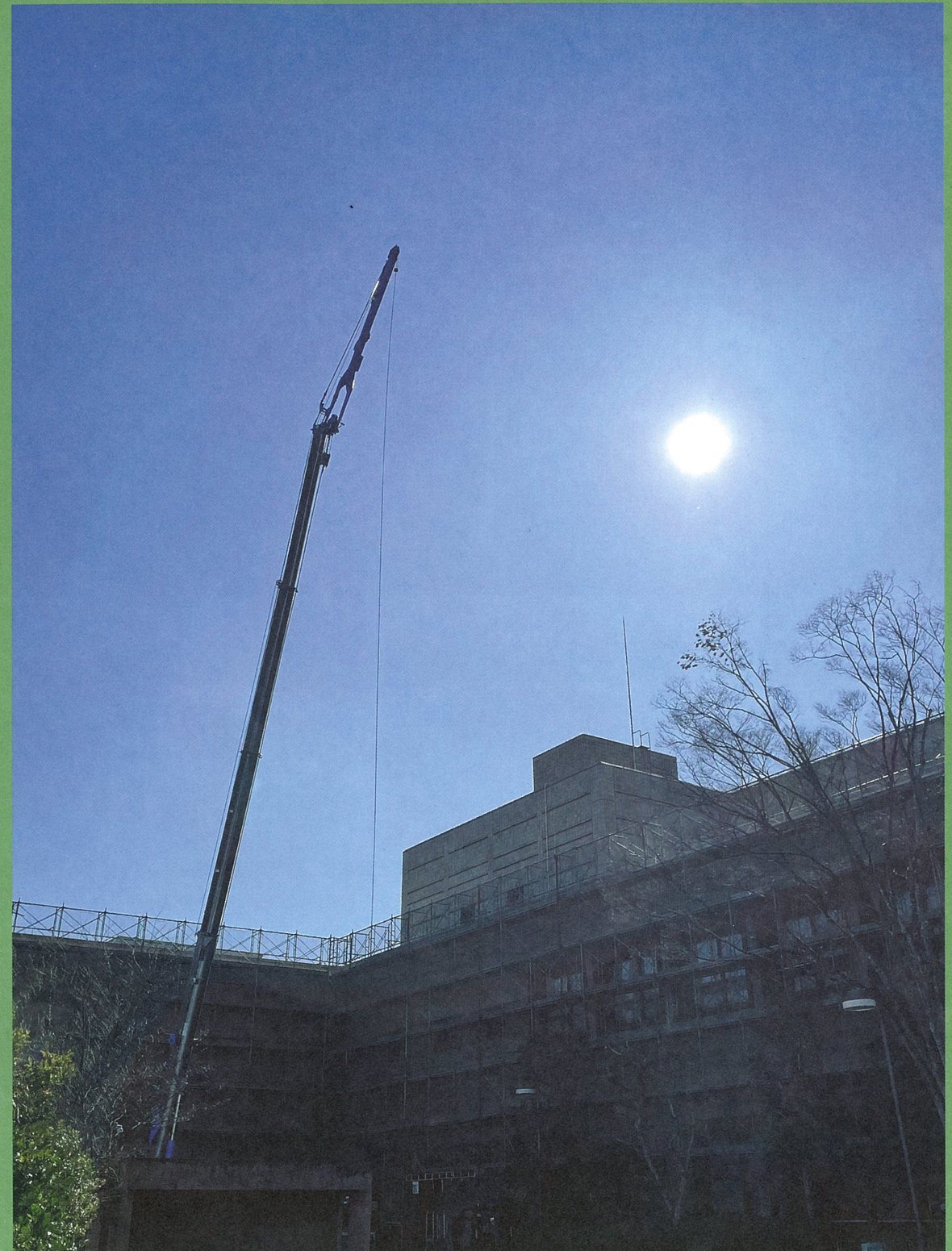
工事中の美術館
