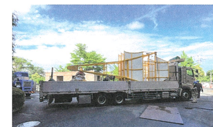
②大型トラックでの輸送
