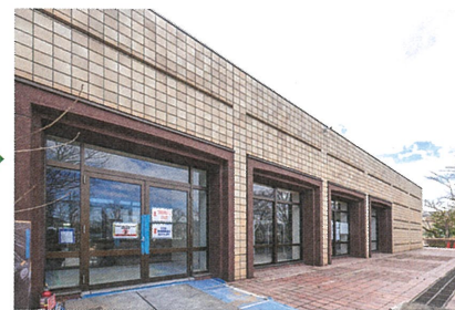
きれいに生まれかわった外壁
